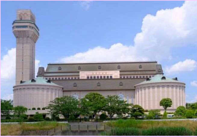
東埼玉資源環境組合 第一工場ごみ処理施設
