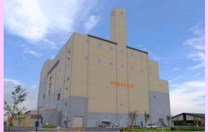
東埼玉資源環境組合 第二工場ごみ処理施設
