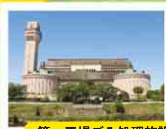
第一工場ごみ処理施設
