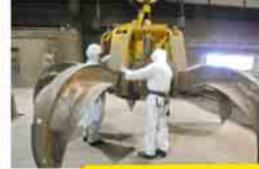
ごみクレーン点検の様子
