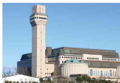
第一工場ごみ処理施設
