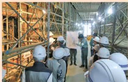
【工事見学会の様子】
