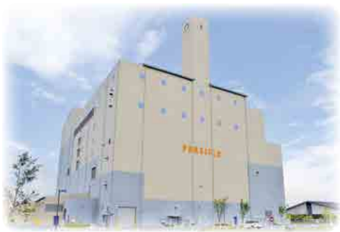
第二工場ごみ処理施設 (愛称パーシクル)
