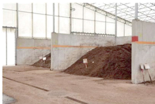
熟成中の堆肥（発酵棟内）
