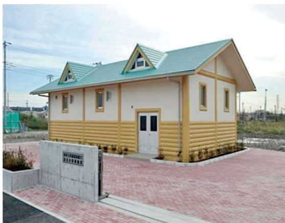
浸出水処理設備の外観
