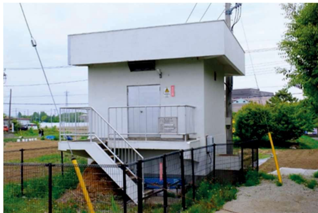
元荒川ポンプ場 正面入口
