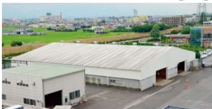
破碎処理棟・発酵棟
