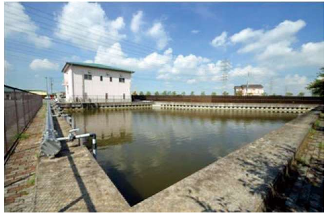
浸出水調整池
