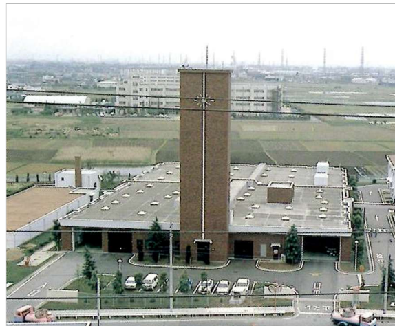
旧第二工場し尿処理施設
