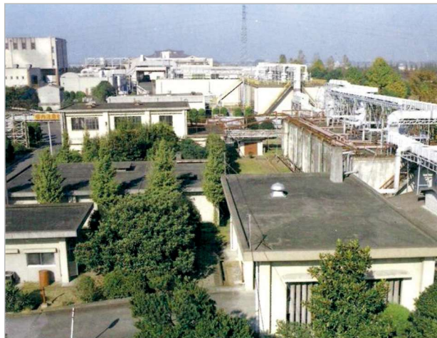
旧第一工場し尿処理施設
