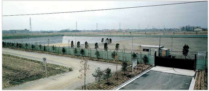
完成時の第一最終処分場
