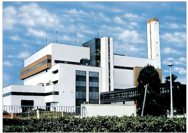
旧第二工場ごみ処理施設
