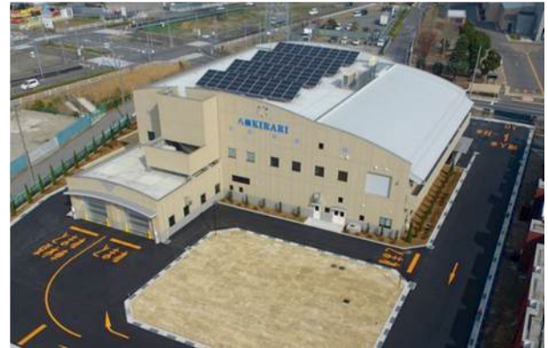
第二工場汚泥再生処理センター 搬入車両入口
