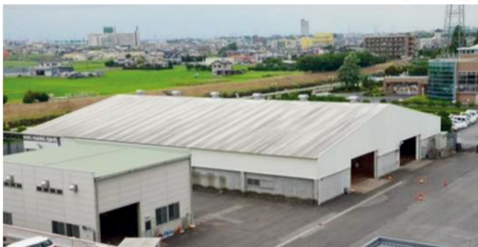
破砕処理棟・発酵棟
