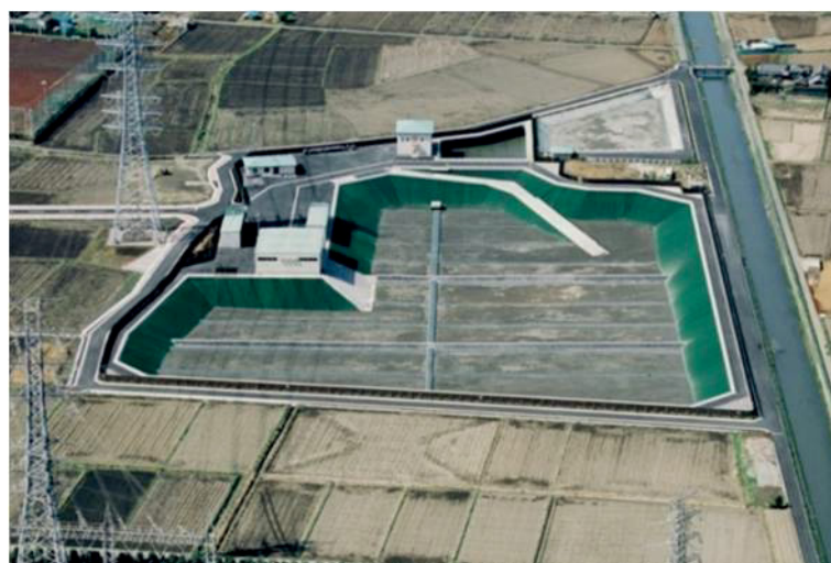
最終処分場建設時
