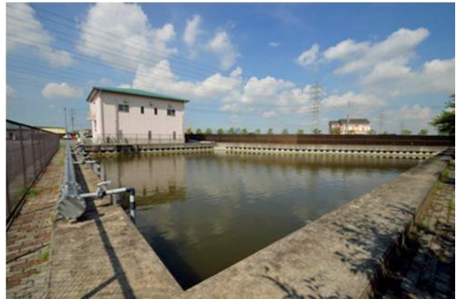
浸出水調整池
