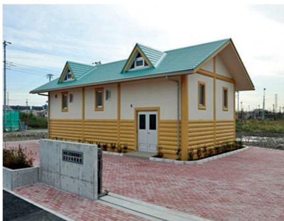
浸出水処理設備の外観
