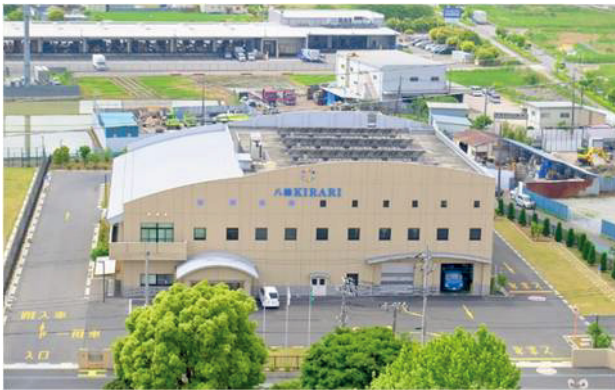
第二工場汚泥再生処理センター 正面玄関
