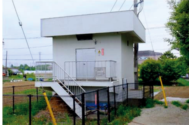
元荒川ポンプ場 正面入口
