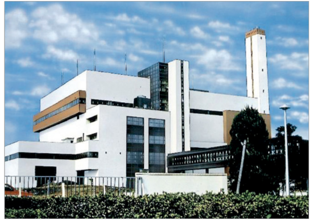
旧第二工場ごみ処理施設
