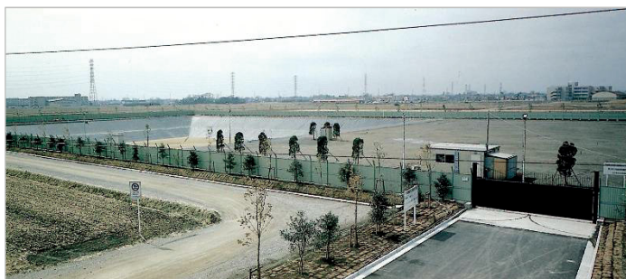
完成時の第一最終処分場
