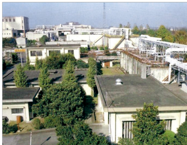
旧第一工場し尿処理施設
