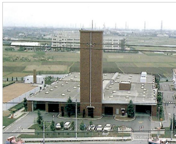
旧第二工場し尿処理施設
