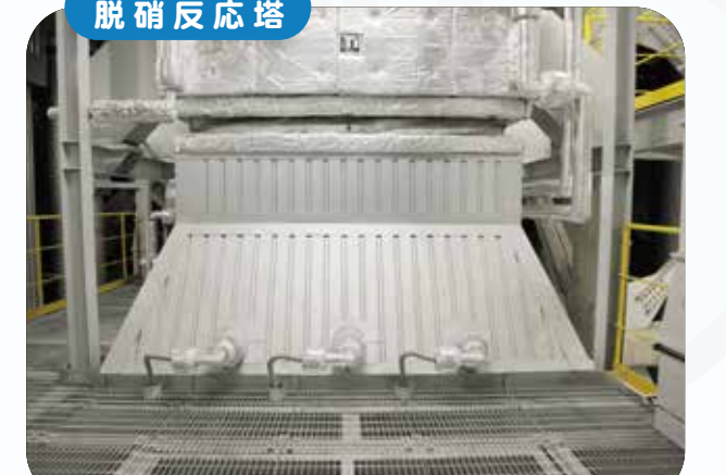
脱硝反応塔
