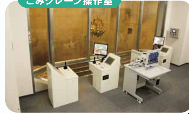
ごみクレーン操作室
