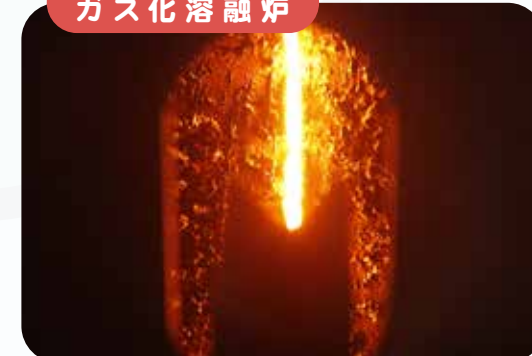
ガス化溶融炉
