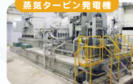
蒸気タービン発電機
