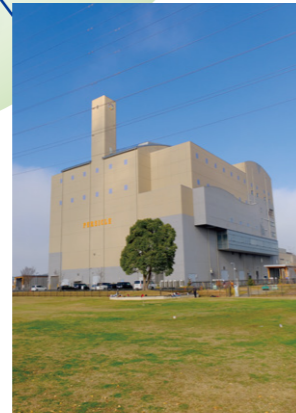
第二工場ごみ処理施設
