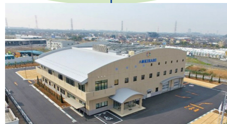
第二工場汚泥再生処理センター
