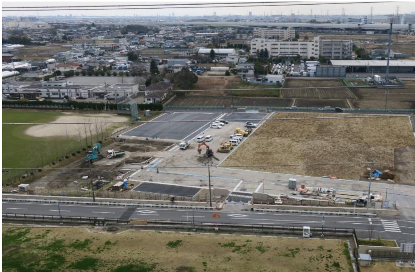
全景写真(ごみ処理施設工場棟より)
