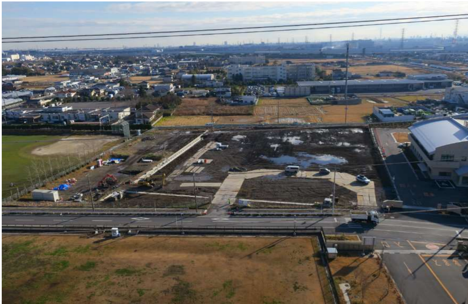
全景写真(ごみ処理施設工場棟より)
