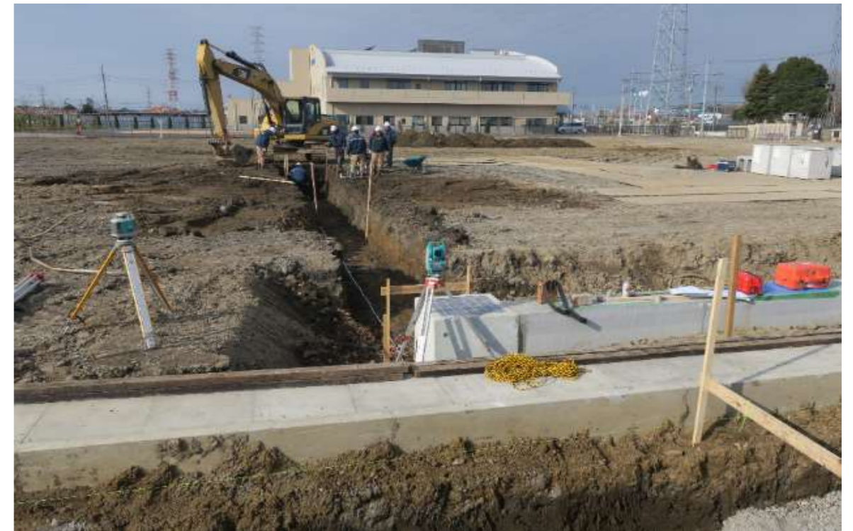
雨水排水構造物設置工事状況
