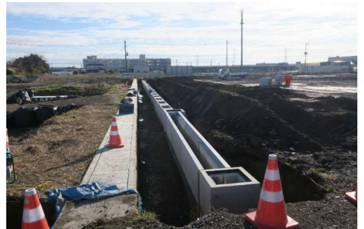
雨水排水構造物(側溝・集水枡)設置状況
