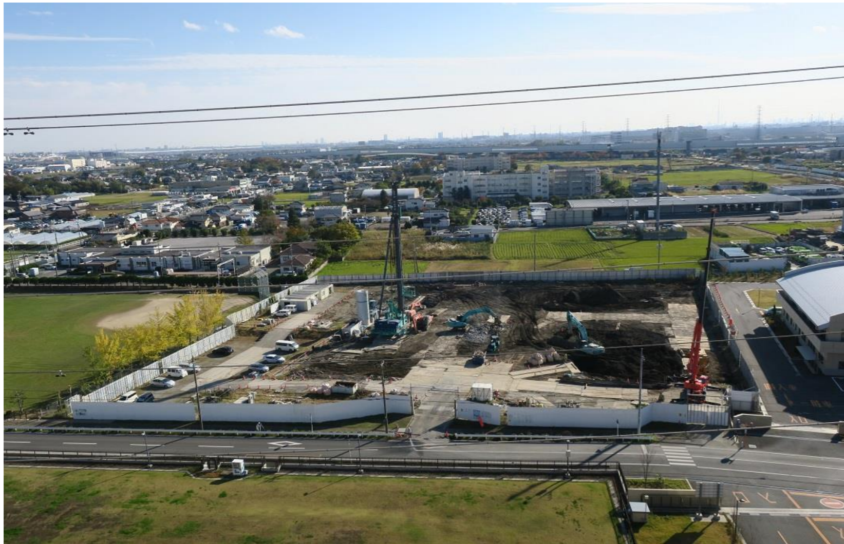
全景写真（ごみ処理施設工場棟より）
