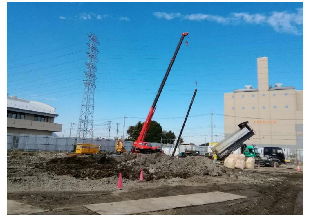
土留め鋼矢板撤去・整地土砂投入状況
