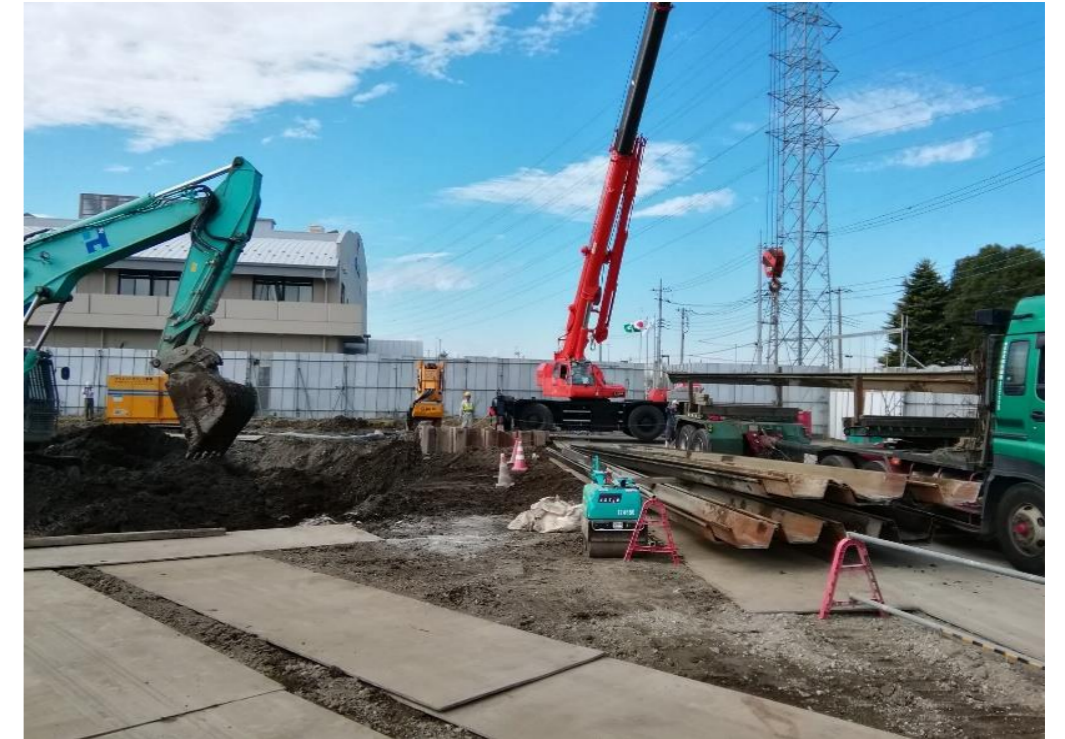
撤去鋼矢板積込状況
