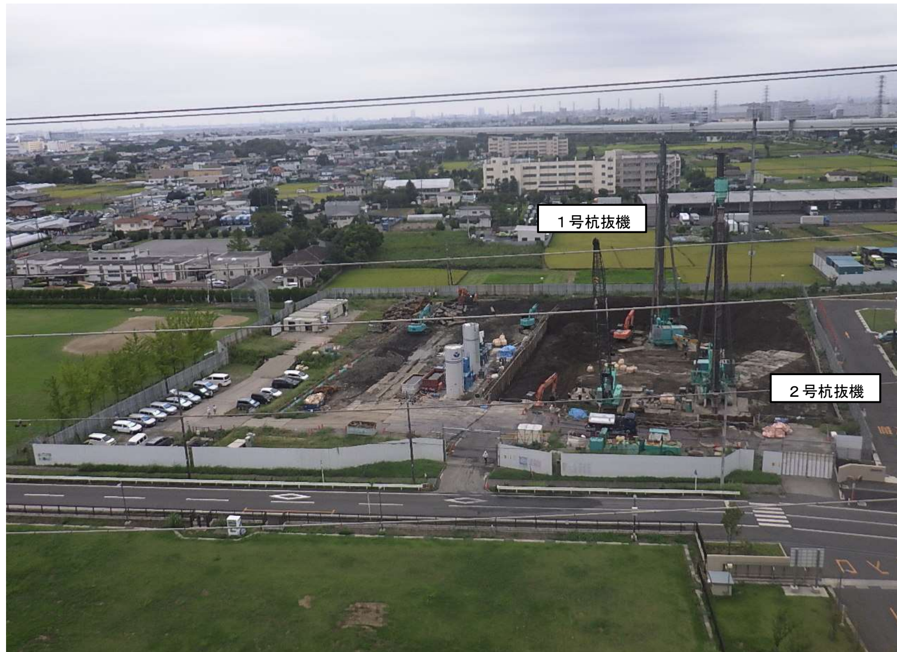
全景写真（ごみ処理施設工場棟より）
