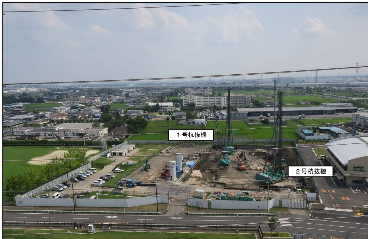
全景写真（ごみ処理施設工場棟より）
