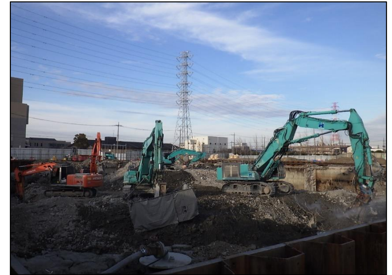
底版及び壁解体状況（処理棟）
