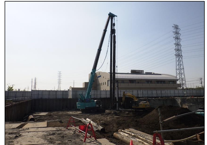
杭抜き状況（処理棟）
