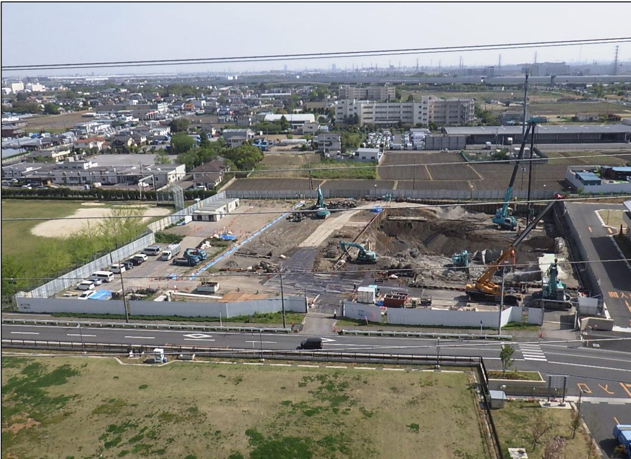
全景写真（ごみ処理施設工場棟より）
