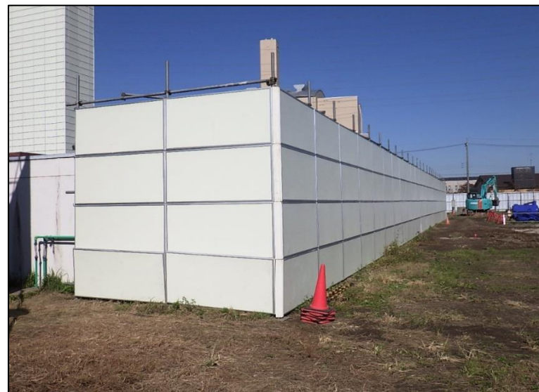
防音パネル設置状況（取水調整槽）
