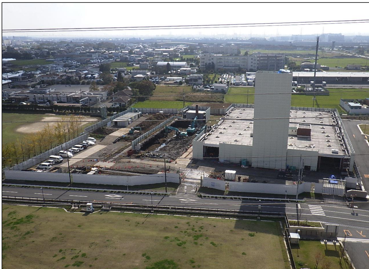
全景写真（ごみ処理施設工場棟より）
