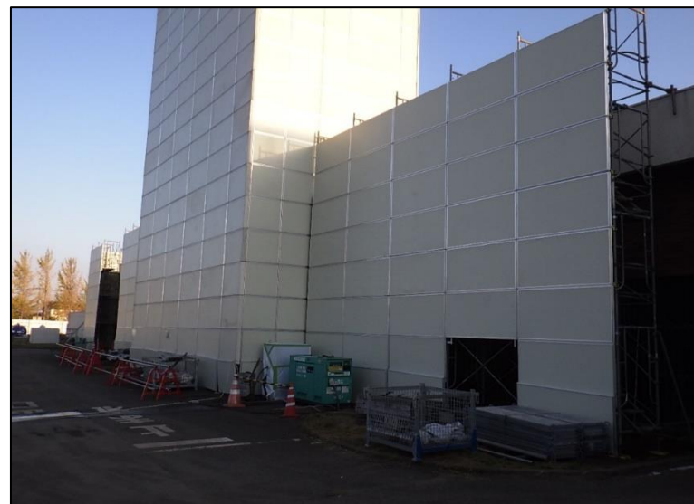
防音パネル設置状況（処理棟）
